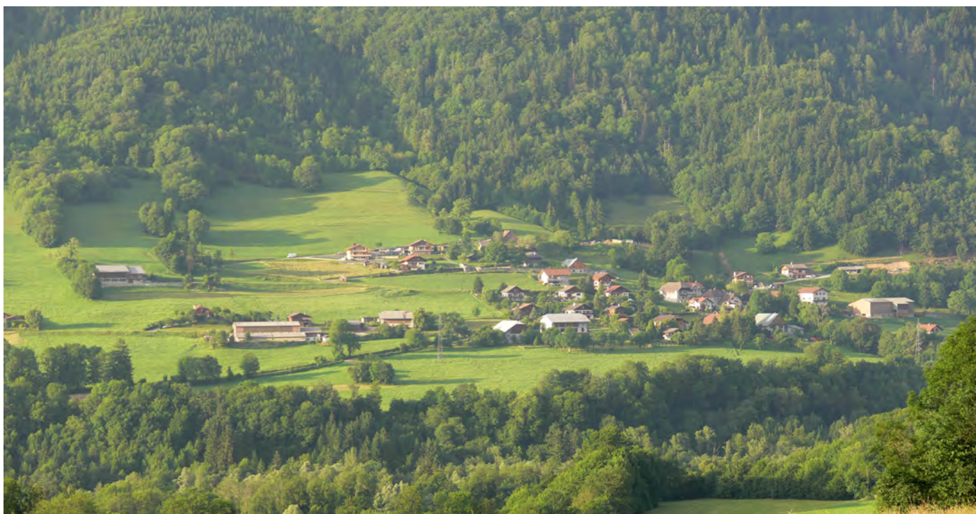
Le glacis agricole de Charvex vu depuis le coteau d'Alex. Le hameau ancien et les extensions contemporaines révélées par les trois bâtiments d'élevage et le "semis" de maisons individuelles sur la pente agricole.
