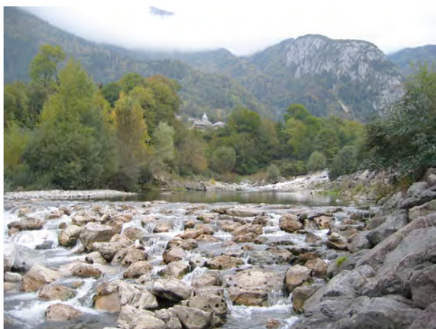
Le contre seuil
