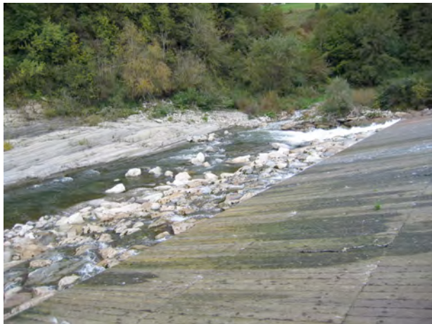
L'aménagement du seuil naturel
