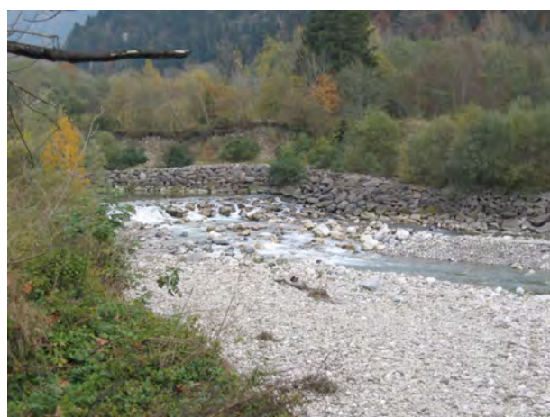
Travaux d'enrochement des berges en rive gauche
