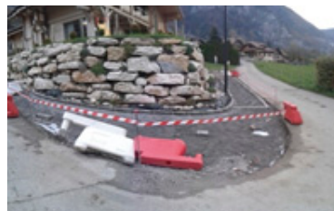
1ère tranche aménagement trottoirs route de la Croix
