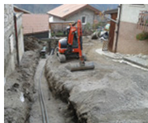
Travaux centre village : Rénovation réseau Eau pluviale, eau potable,
