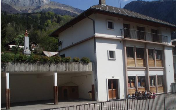
En façade sud, suppression des bandeaux béton et isolation complète de la façade. En partie basse avec habillage bois.
