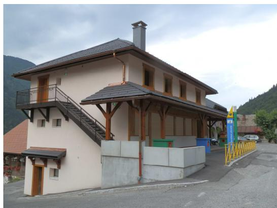
En toiture, les anciennes tuiles ont été déposées et remplacées, un papier pare-pluie, l'isolation des combles et chenaux cuivre ont été installés.
