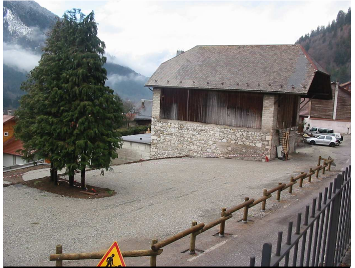
Le parking en cours de réalisation
